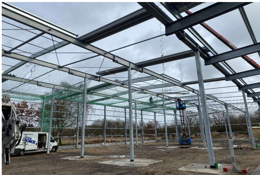
Abnetzen und Vorbereitungen des neuen Anbaus DEG Schenefeld
